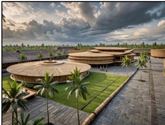
Gambar. 3. Pemandangan Udara Fasilitas MICE yang Diusulkan. Gambar ini menunjukkan aplikasi desain material bambu dan mendukung konsep venue berkelanjutan
