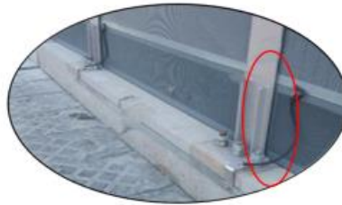
Gambar 3.2. Perangkat Pembumian 接地装置 (Jiēdì zhuāngzhì)
