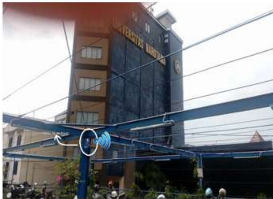
Gambar 10. Pemasangan Access Point
