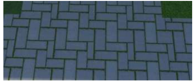
Gambar 4.18 Paving untuk Lantai Trotoar Sumber: Dokumentasi Pribadi
