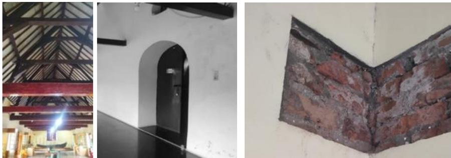
**Gambar 3.3** Atap Konstruksi Kayu, Foto Dinding Batu Bata dengan Tebal 60 cm
