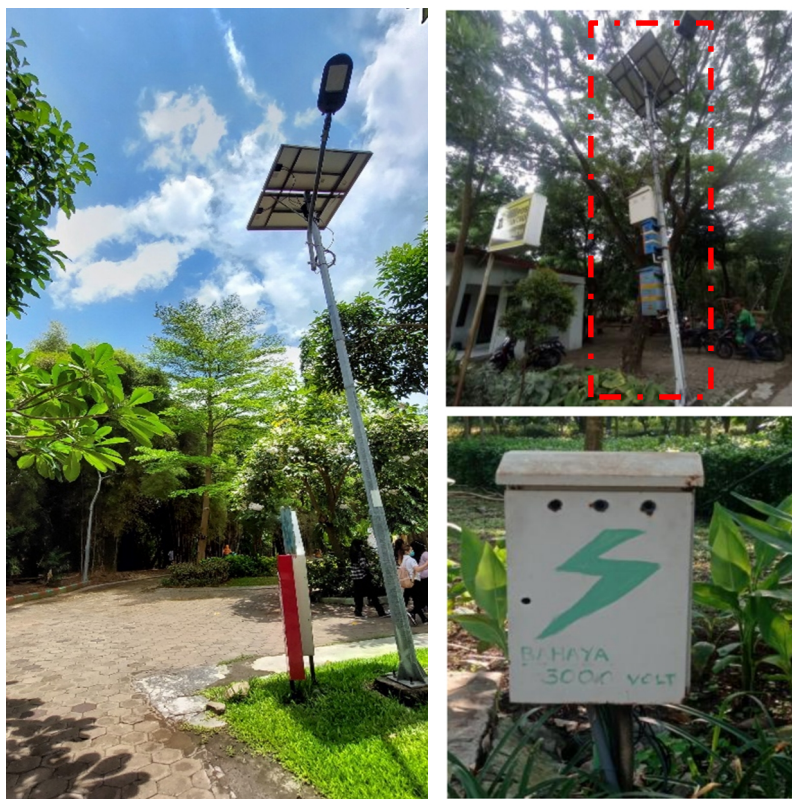
Gambar 3.7 Penggunaan Sumber Listrik Pada Taman Harmoni Surabaya.
