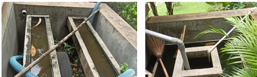
Gambar 4.4 Pengolahan air hujan pada Taman Prestasi (Dokumen Pribadi)
